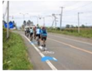
路面への通行位置明示
